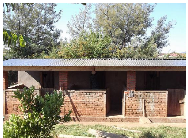
« Pendant les travaux de réhabilitation de la porcherie »
